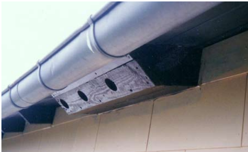
Passgenauer Holzkasten zwischen Balkenköpfen
