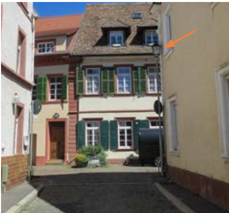
Unpassende hohe LPH, Provisorium in der Rathausgasse
