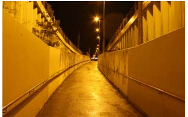
Nordaufgang S-Bahn Böbig
