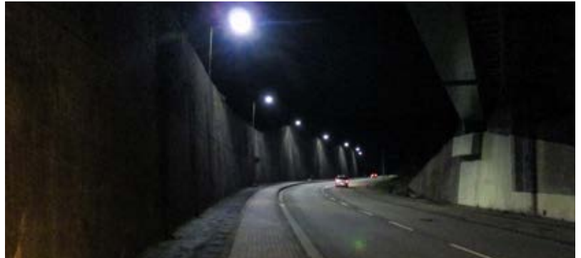
Betonstützmauern im Schöntal an der B39
