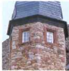
Bruchstein-Mauerwerk
